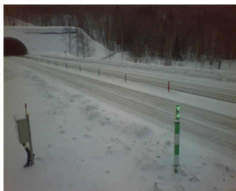
写真-7.2 コンクリート舗装の路面状況
