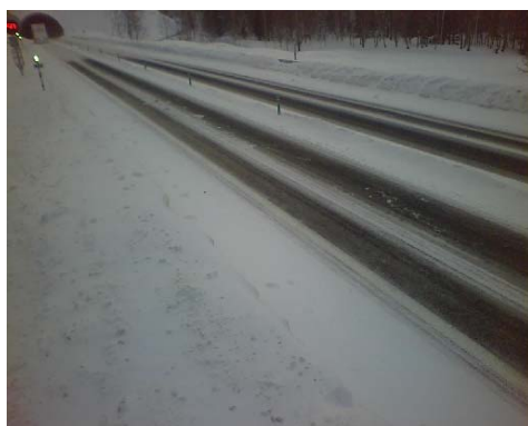
写真-7.1 アスファルト舗装の路面状況
