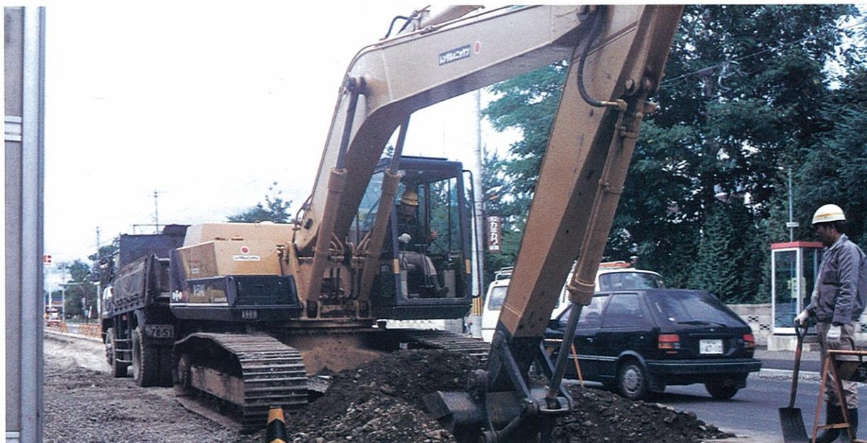
現在の機械+ダンプトラックの組合せによる掘削と運搬作業
