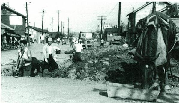
昭和30年代初期の人力+馬車の組合せによる掘削と運搬作業
