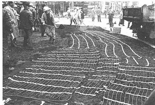
昭和38年施工中の薄野地区のロードヒーティング（提供：三浦 宏）
