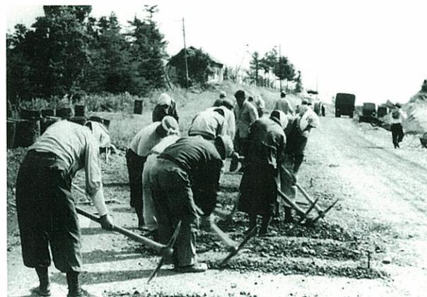
昭和30年代の人力による路盤の整正作業
