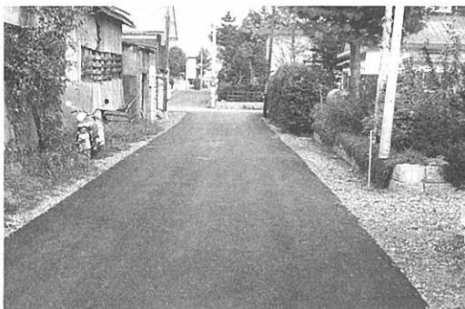
加熱混合物による防塵処理
