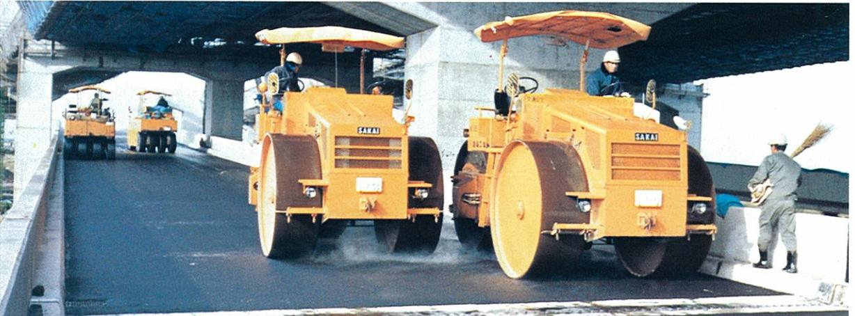
現在の複数のマカダム+タイヤローラ組合せによる締め固め作業
