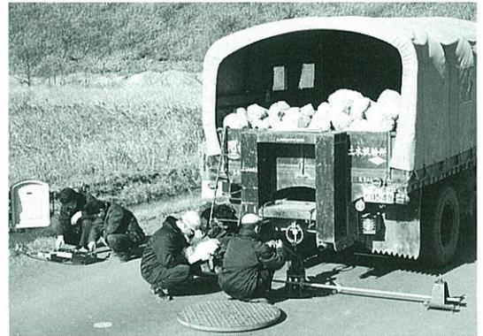
昭和30年代の平盤載荷試験
