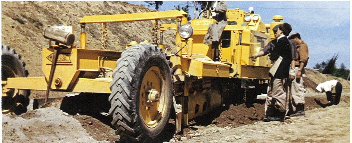
昭和30年代後期のロードミキサによる混合作業
