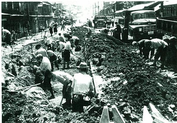
昭和30年代初期の人力+トラックの組合せによる掘削と運搬作業
