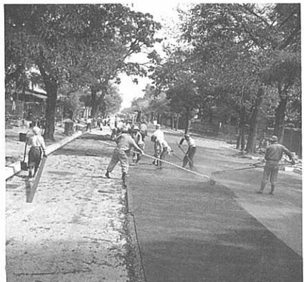
アスファルトモルタル工の人力舗設
