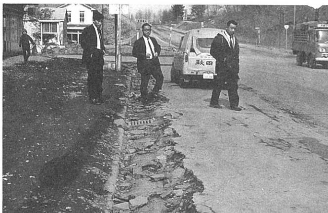
凍上による被害調査（昭和26年大樹町にて）（提供：土木試験所）
