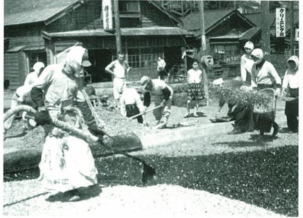
昭和30年代初期のアスファルトの散布と箕による目つぶし材の散布
