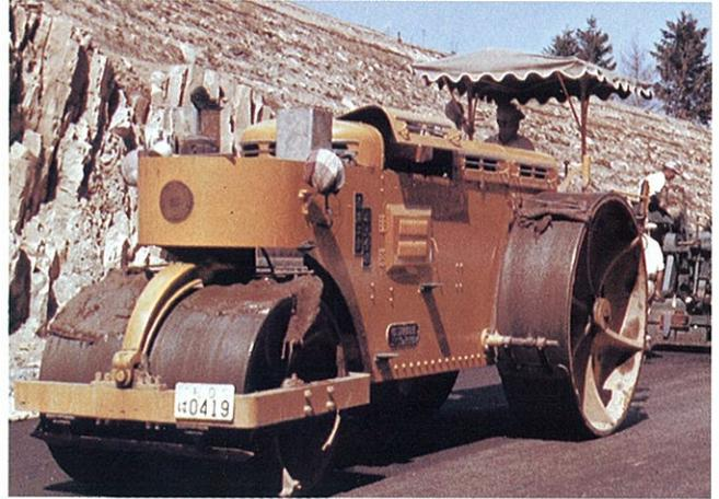
昭和40年代中期のマカダム+タイヤローラによる締め固め作業
