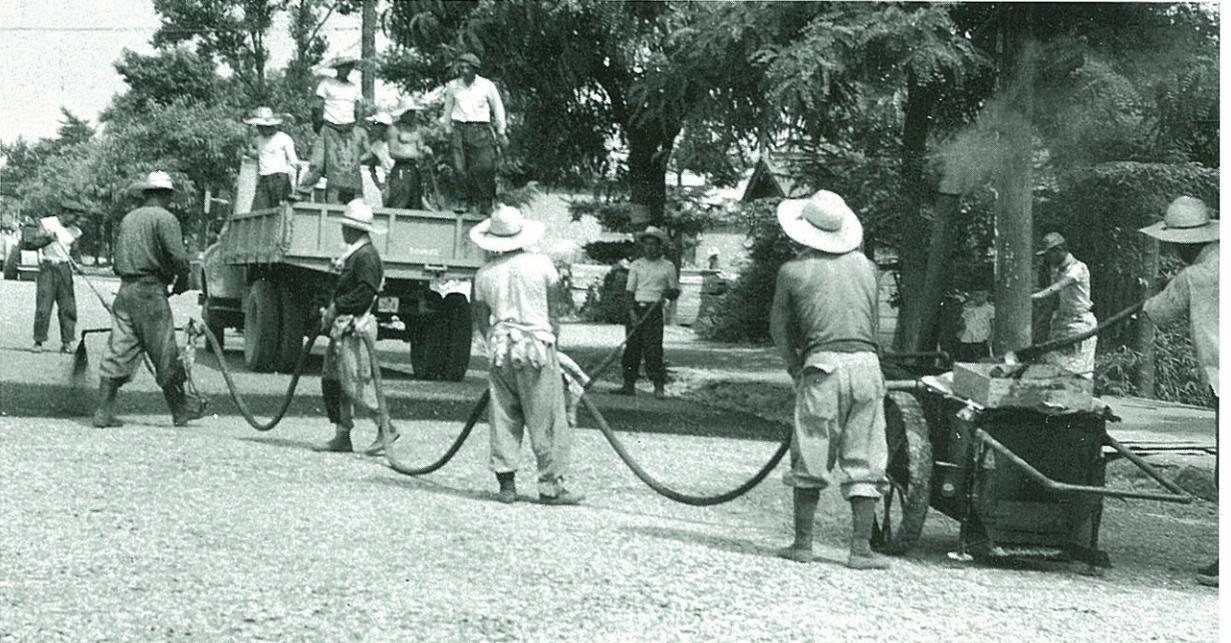
昭和30年代初期のアスファルト散布と目つぶし材の散布
