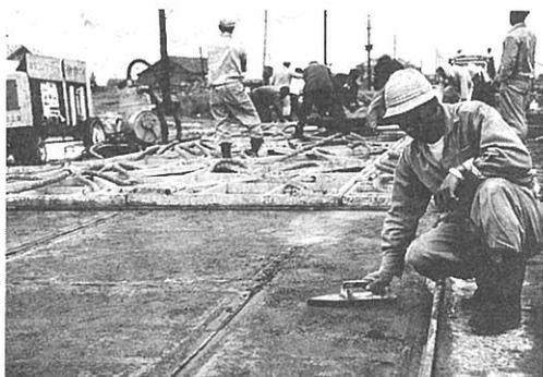
コンクリートを打設した直後に、その表面に真空マットを置き、これに振動を与えながら減圧脱水を行うことを特徴とする施工法は特許である。また、真空マット設備は実用新案である。
