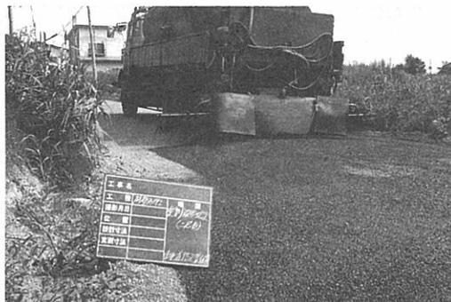
アスファルト乳剤散布による防塵処理
