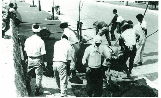
昭和30年代中期の人力による敷きならしとハンドローラによる締め固め作業
